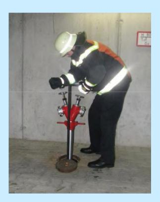
Vollständiges Öffnen des Hydranten mit dem Schlüssel C.
