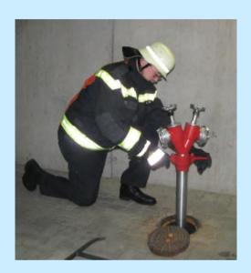
Einsetzen des Standrohres in den Klauensitz und rechts herum festdrehen.
