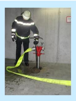
Öffnen des Absperrventils und füllen der Schlauchleitung. Der Unterflurhydrantenschlüssel (Schlüssel C) verbleibt nach Öffnen des Hydranten auf der Hydrantenspindel aufgesteckt. Der Rückbau erfolgt sinngemäß in umgekehrter Reihenfolge.
