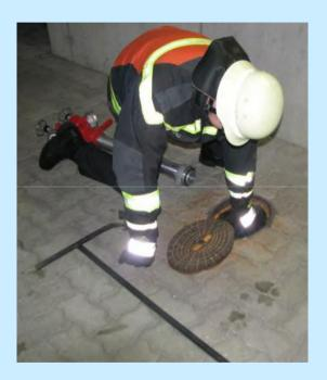
Entfernen der Staubklappe; ggf. Reinigung des Klauensitzes
